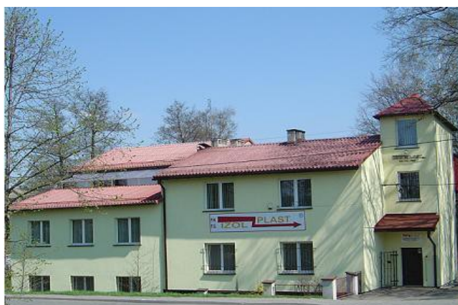
Budynek produkcyjny PPHU Izol-Plast Sp. z o. o.
