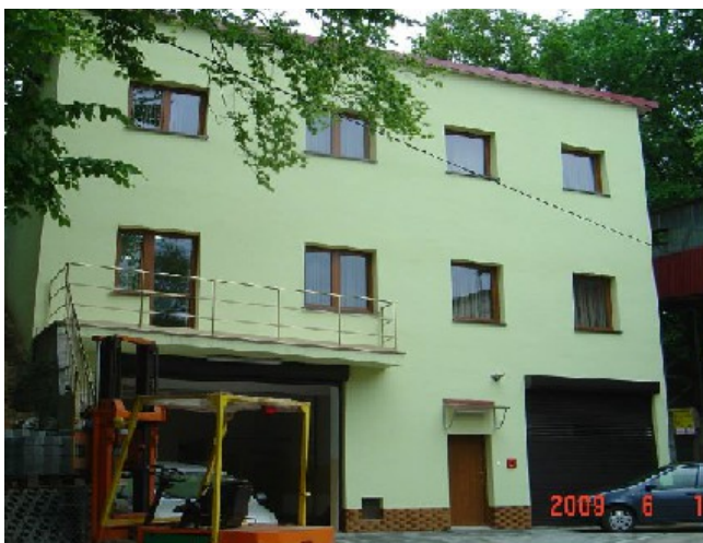
Budynek produkcyjno-socjalny PPHU Izol-Plast Sp. z o. o.
